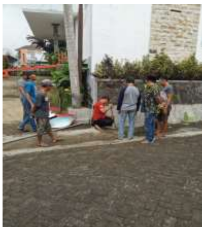
Gambar 9. Proses penggalian tanah untuk pondasi
