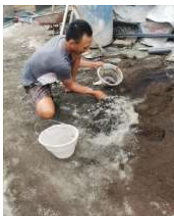
Gambar 10. Proses Persiapan Pemasangan Pondasi dan pengecoran
